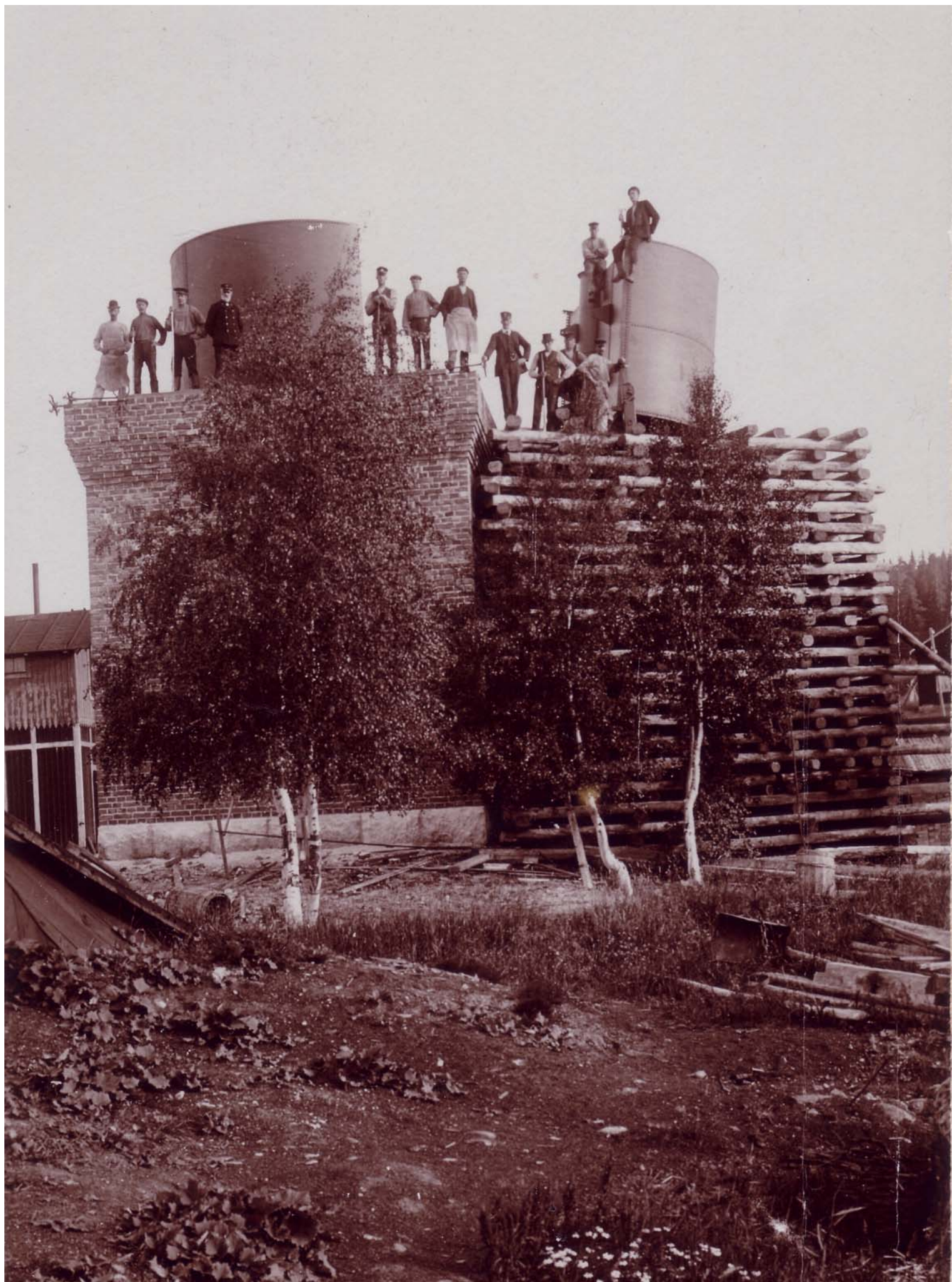
16. Ett nytt större pumphus byggs för att ersätta det gamla som skymtar till vänster.
