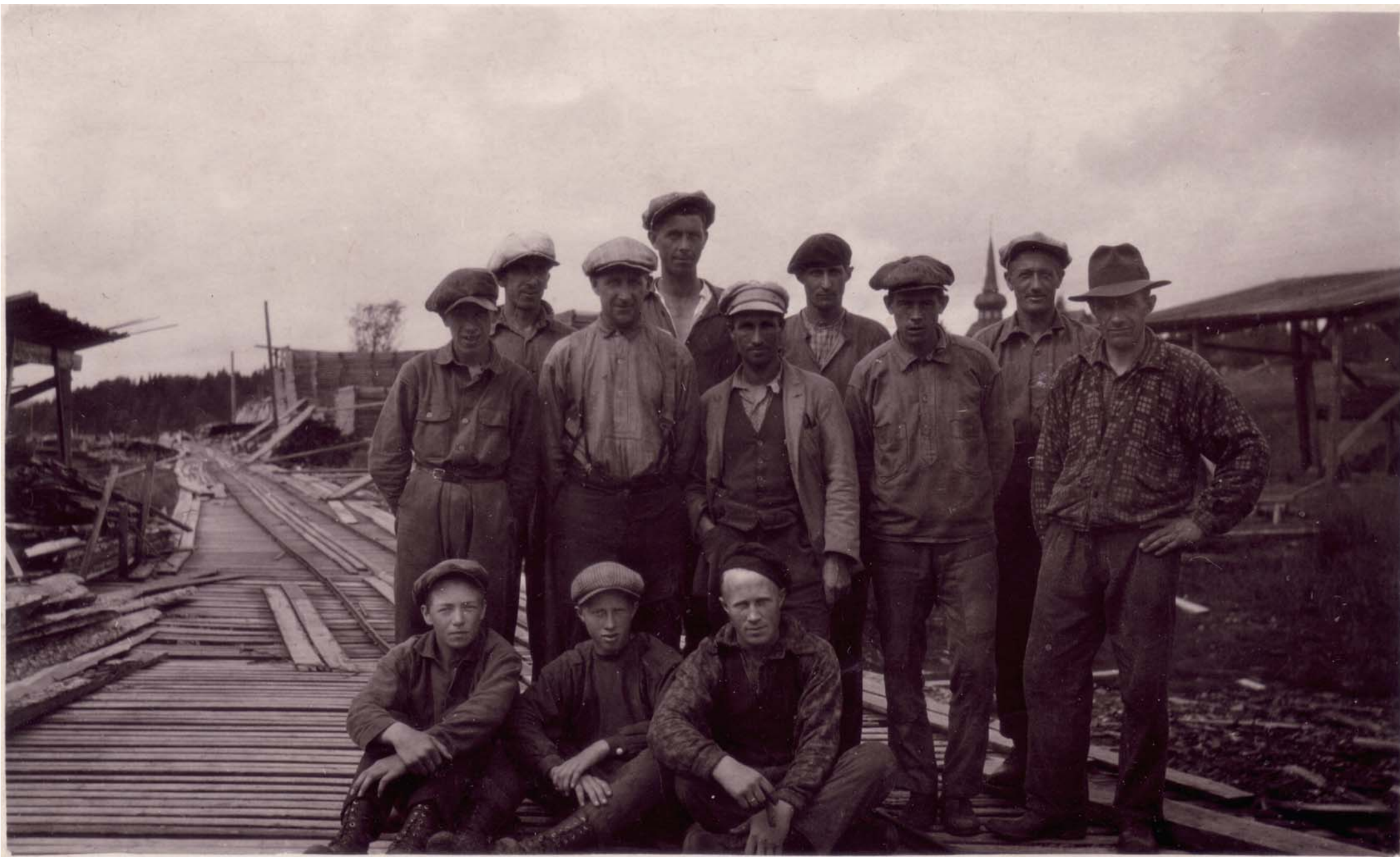
40d. Sågverksarbetarna på Vallsågen med smalspåret och klockstapeln i bakgrunden 1933.
