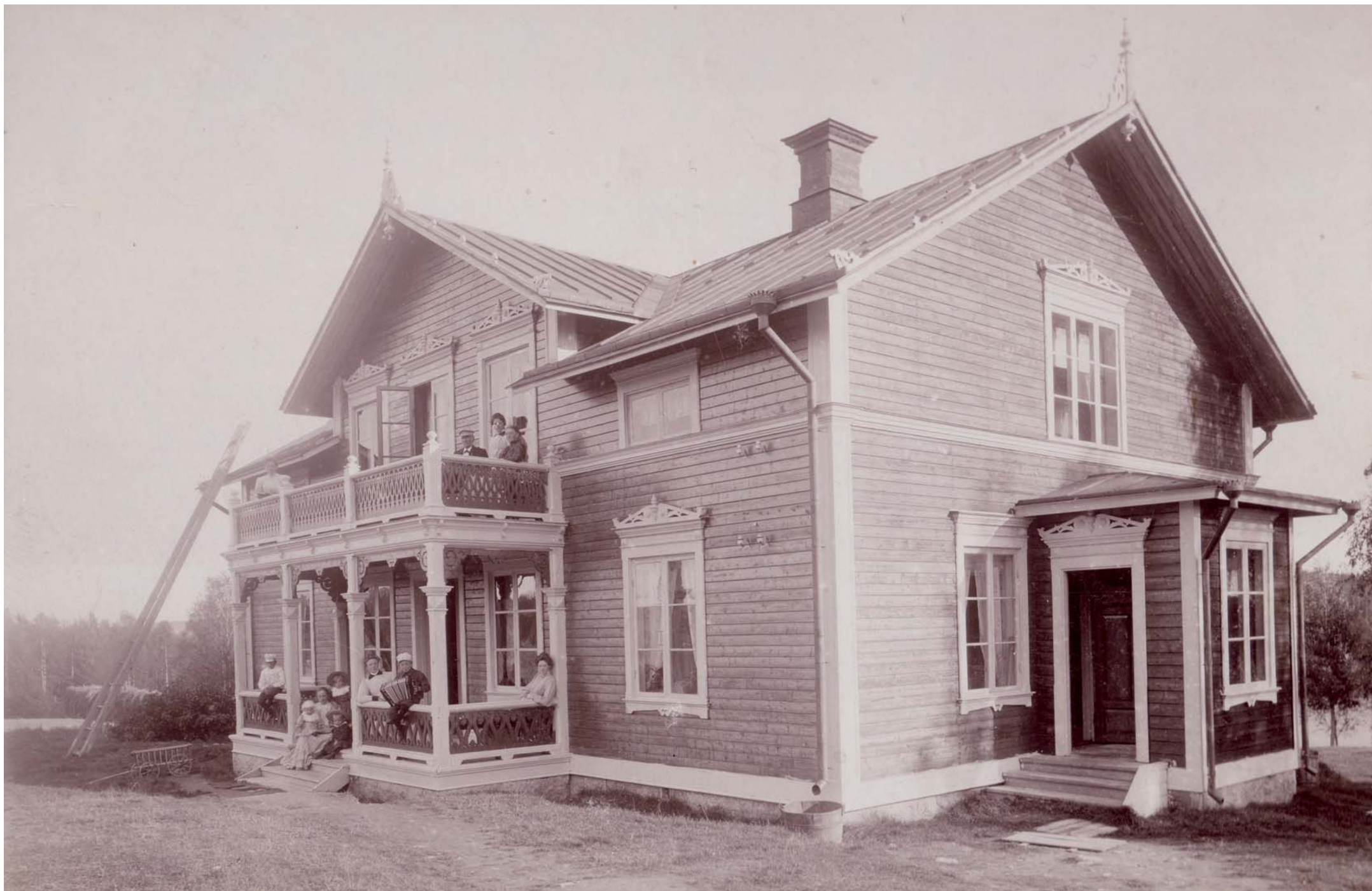
32. Handlanden Petter Östbergs nya huvudbyggnad från gårdssidan 1906.
